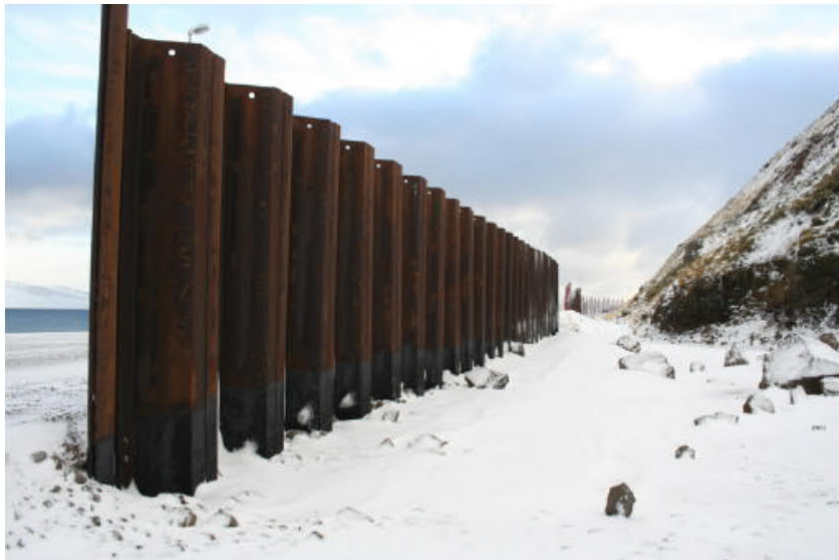
Mynd 15. Stálþil notað sem snjóflóðavörn við Óshliðarveg. Vegskápurinn er hægra megin á myndinni. Ljós. Árni Jónsson 10/2005.
